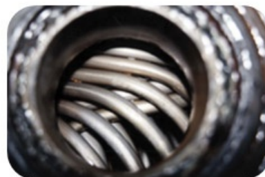
Widok spasywowanych rurek wymiennika (metaliczny połysk) po zakończeniu procesu chemicznego oczyszczania i pasywacji.
